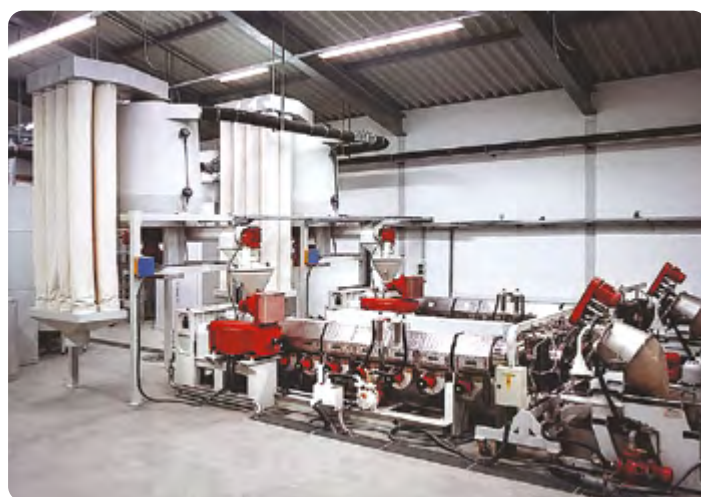
Linea di granulazione | Pelletizing line
