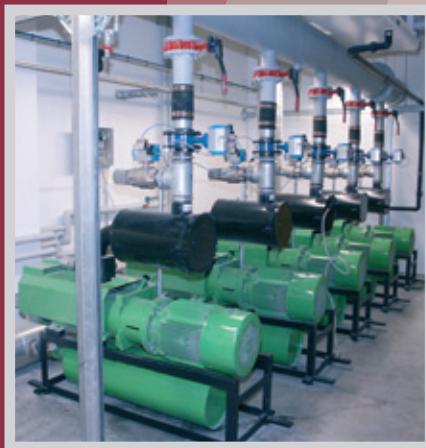
Vakuumzentralversorgung 5500 m³/h. Granulatförderung mit Wärmerückgewinnung aus der Abluft / centralized system 5500 m³/h. polyamid conveying with heat recovery.
